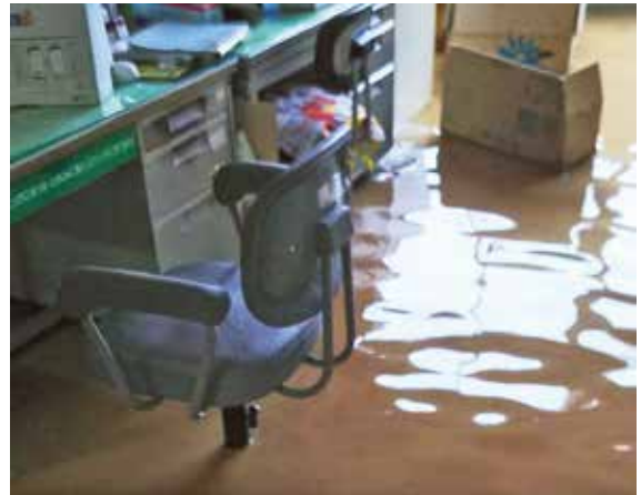
(写真 宇和島市提供) 吉田支所内
